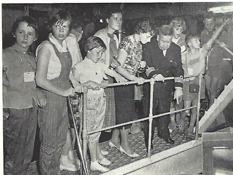
Met kennelijk ontzag wordt de machinekamer bekeken
